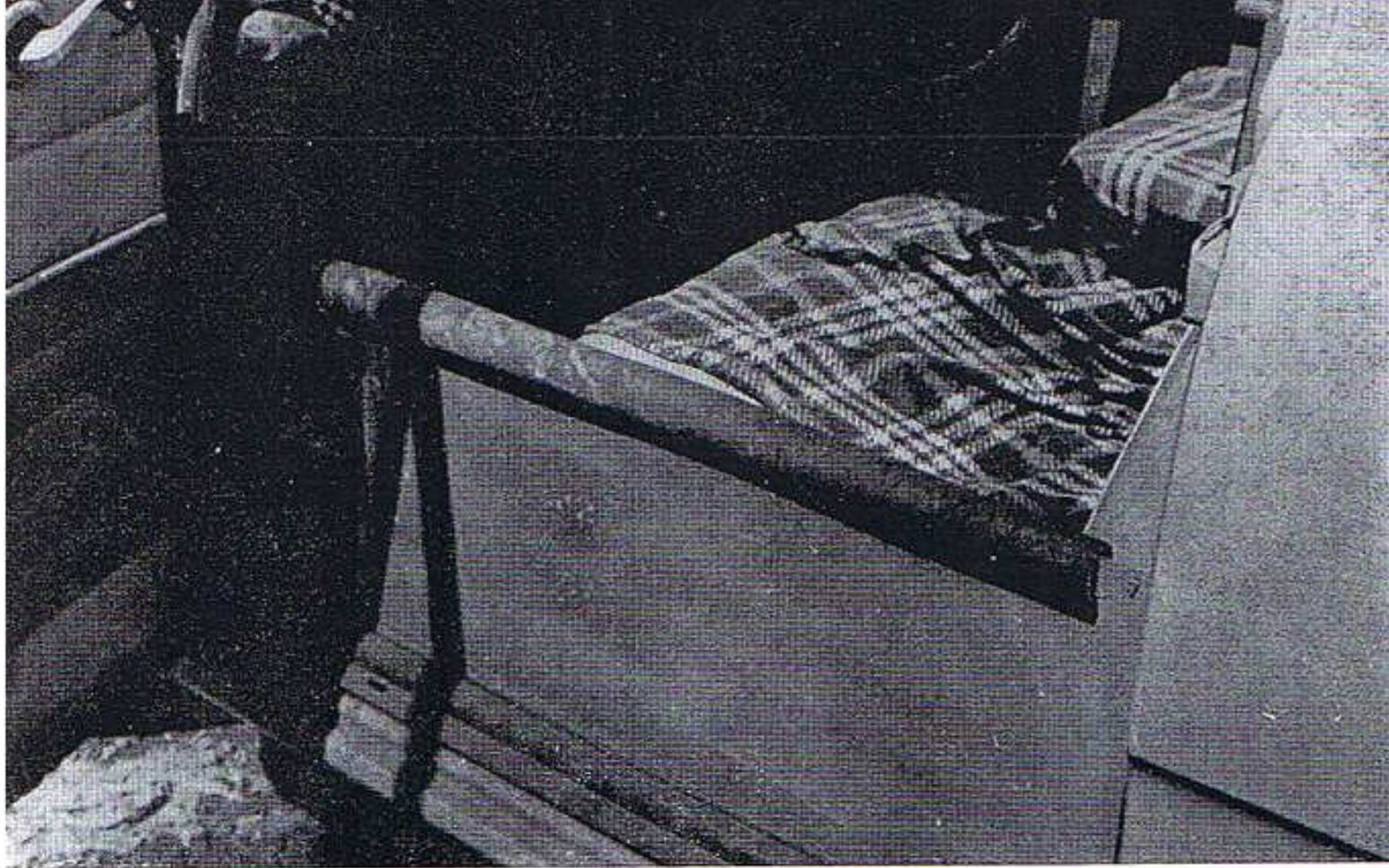
Das angeschweisste Blech verhindert das Eindringen von Wasser in die Kabine durch die Türspalte.
