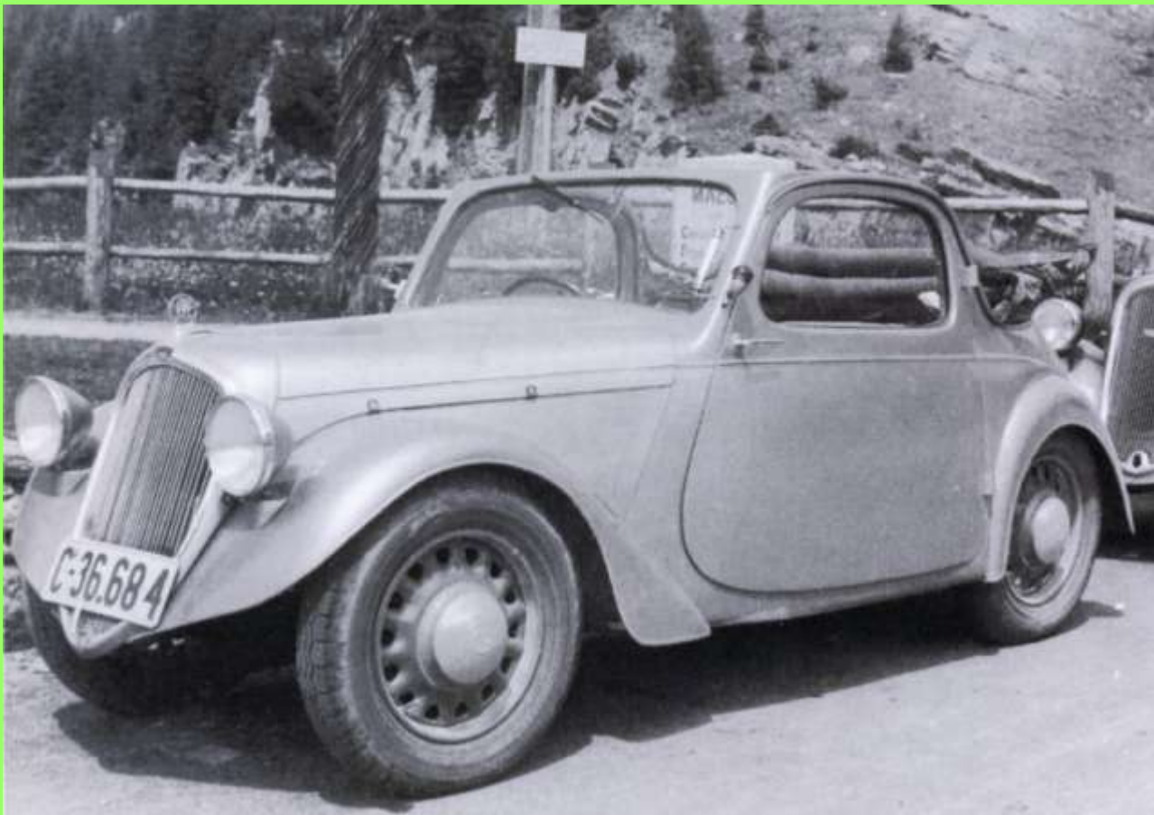
Eines der zwei Prototypen mit 2+2 Kabriokaroserie (weiter noch 4 Coupe und 1 Vierplatz-Tudor)
